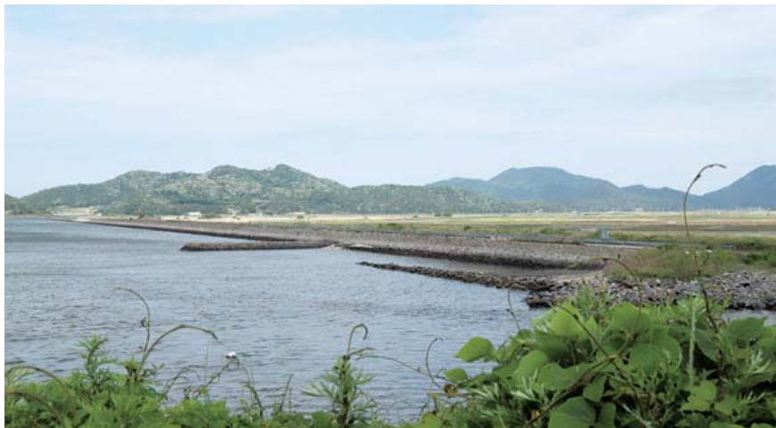
진도군 임회면 팽목리와 진도군 지산면 마사리를 잇는 팽목방조제는 길이가 1.8km에 이른다. 1966년 방조제가 완공되면서 안쪽에 396ha의 간척지가 생겼다.
