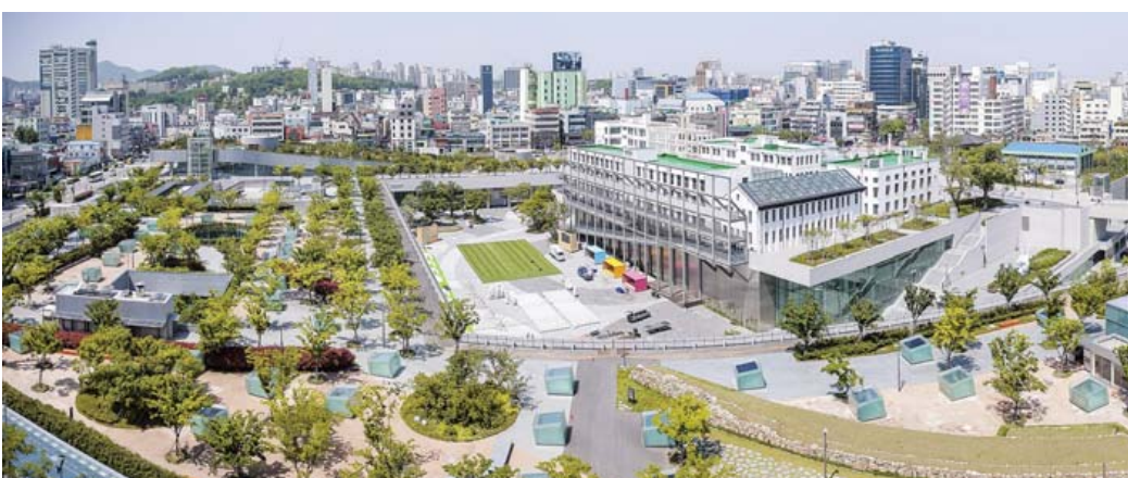
국립아시아문화전당은 5·18민주화운동의 마지막 항쟁지인 옛 전남도청을 중심으로 두고 현대식 건축물 대부분이 지하에 배치돼 있으며 옥상에는 공원이 조성돼 있다.
