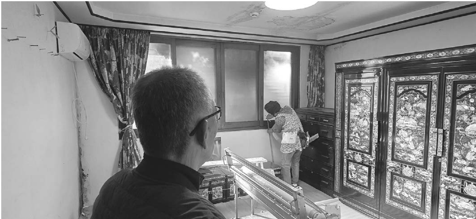
전남사회복지공동모금회는 올해 처음 취약계층의 주택 개보수를 지원하는 ‘기후위기 취약계층 House Care’ 사업을 추진했다. 사진은 나주시 금당면 한 단독주택에서 거주자 박종식 (65)씨가 곰팡이 핀 낡은 벽지를 걷어내고 새 도배를 하는 작업자를 지켜보는 모습. /주성학 기자
