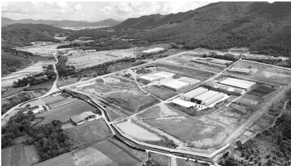
해남군 삼산면 평활리에 조성 중인 농업연구단지 전경(왼쪽). 농업연구단지 조성 조감도.
