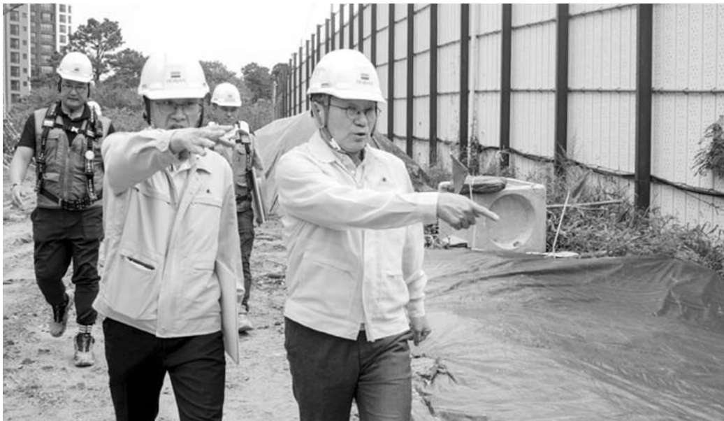
강시장, 토사유출 현장 점검
