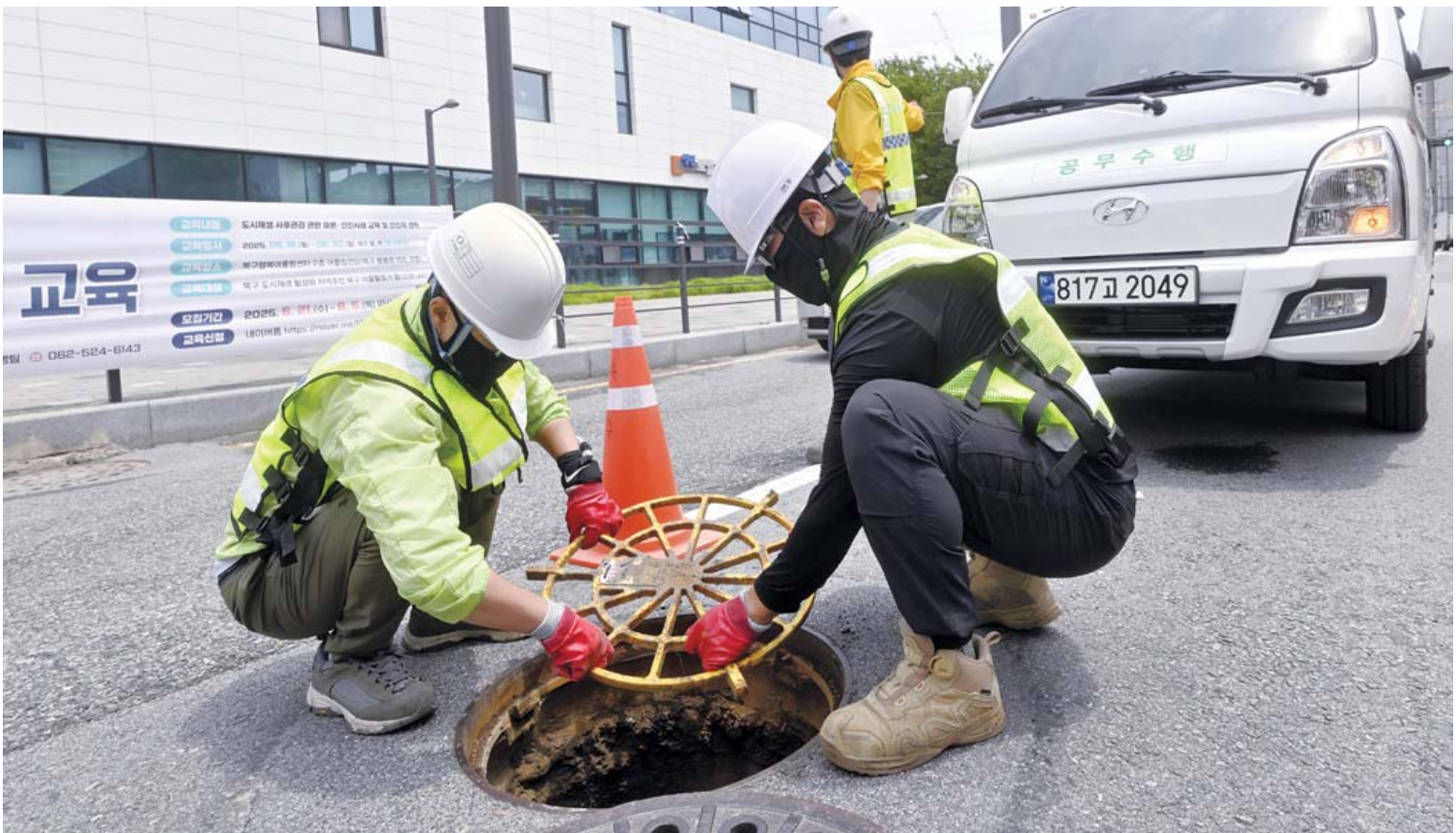
장마 앞두고 맨홀 안전점검 본격적인 장마철을 앞두고 17일 광주 북구 하천방재과 하수팀 직원들이 북구청 교차로에서 전대 정문 구간에 설치된 맨홀 추락 방지 안전망을 점검하고 있다. 광주지방기상청은 광주·전남 지역에 오는 20일부터 장마가 시작될 것으로 예보했다. /김예리 기자·조영권 인턴 기자
