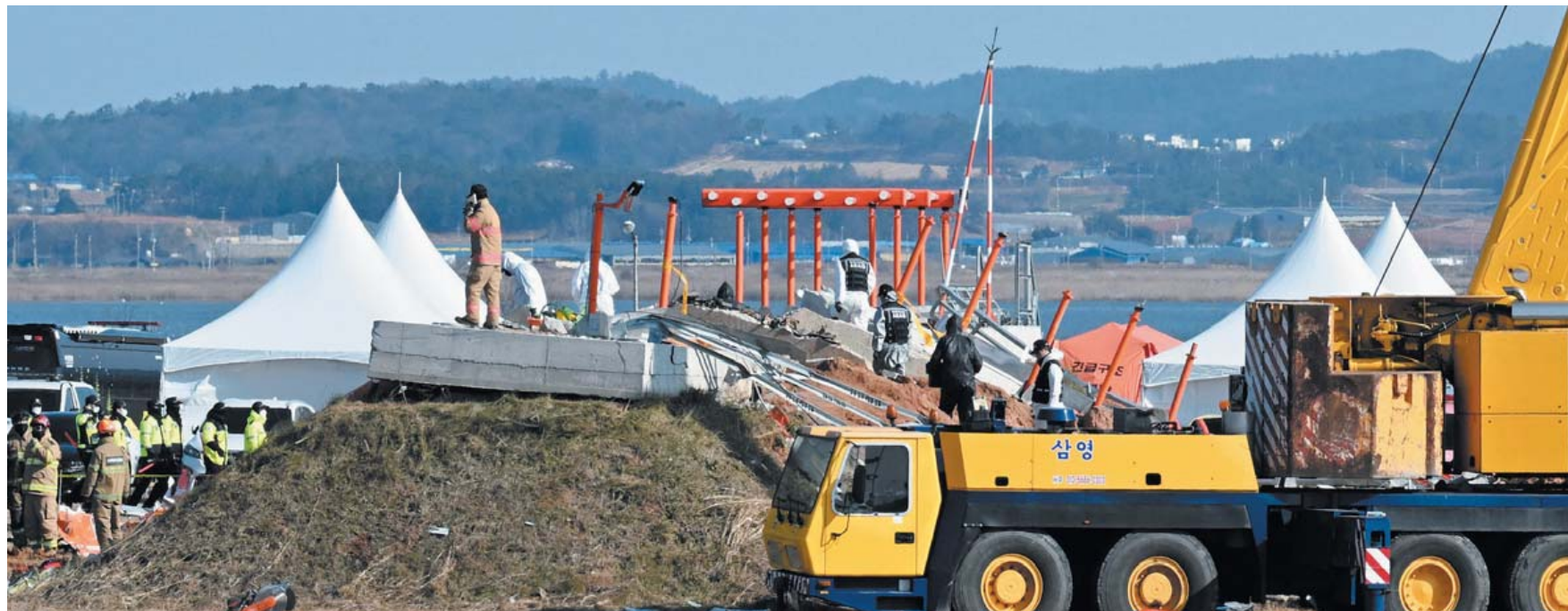
방위각 시설 '둔덕' 조사 2일 오후 무안국제공항 제주항공 참사 현장에서 합동조사단 관계자들이 활주로 끝에 설치됐던 방위각 시설(로컬라이저)의 기반이 된 콘크리트 구조물(둔덕)을 조사하고 있다. 국토교통부는 무안국제공항에서 발생한 제주항공 참사의 피해 규모를 키운 것으로 지적된 방위각 시설의 둔덕과 관련해 전국의 공항 시설에 대한 전수조사에 착수했다. /특별취재반=김애리 기자
