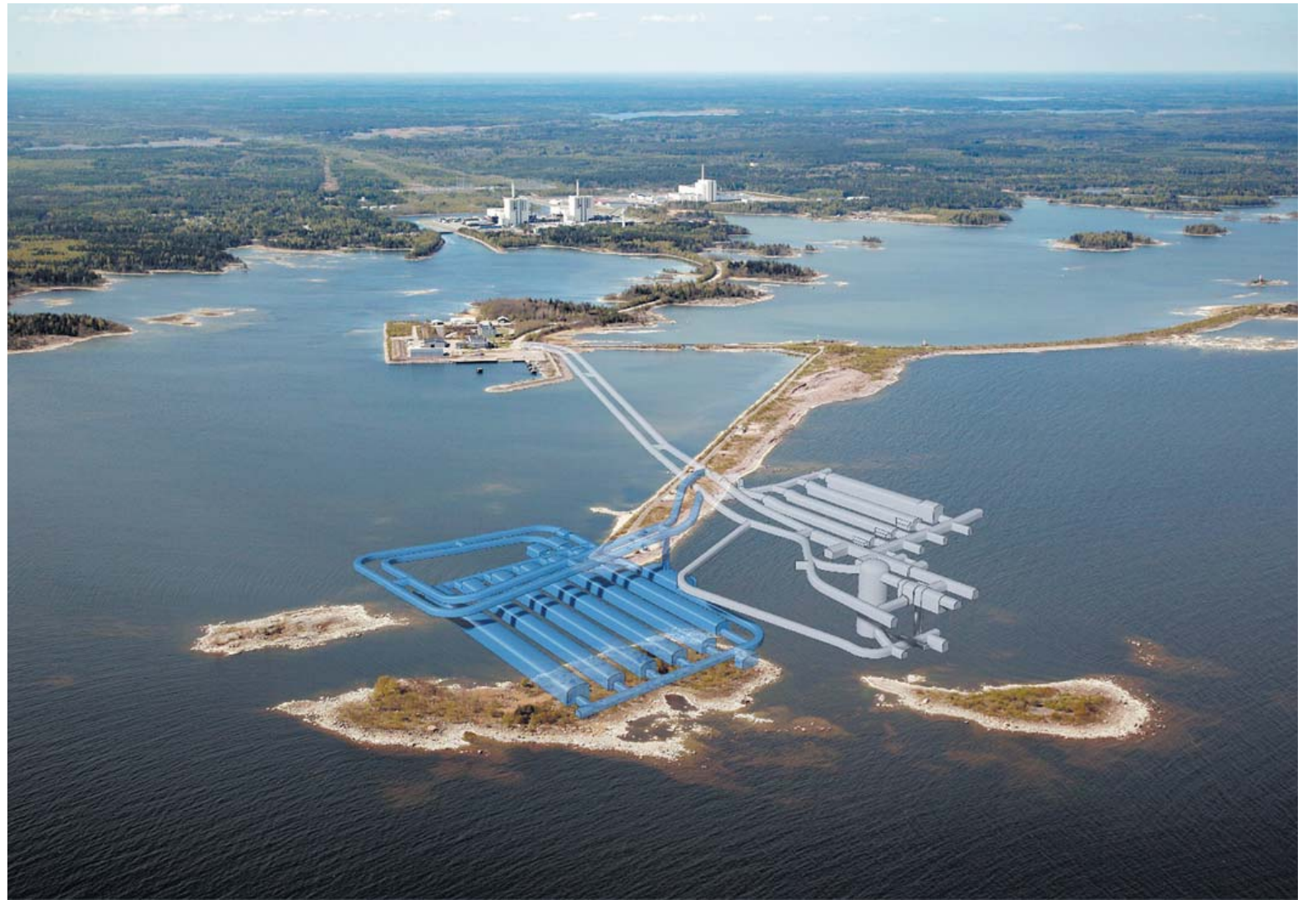
세계 최초 고준위 방폐장이 될 핀란드 심층처분장 '온칼로'의 조감도. 온칼로 건설을 위해 1983년부터 부지 물색에 나선 핀란드는 17년에 걸쳐 '울킬루오트 섬'을 확정했다. 현재는 2025년 운영을 목표로 막바지 공사 중이다.
