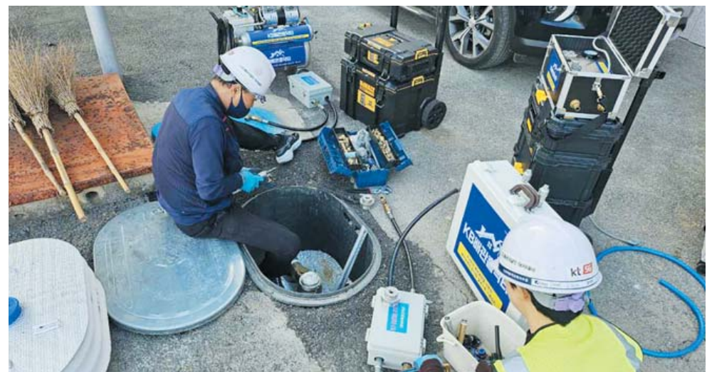
해신개발은 물과 공기파동, 나노기술을 적용한 친환경 배관 세척 방식을 통해 99.99%의 세균을 제거한다.
