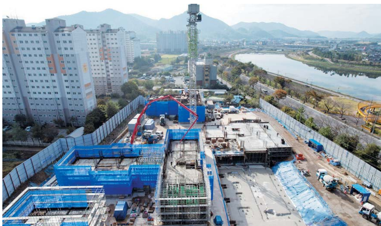
장성 남양휴튼 리버파크아파트가 지하 1층-지상 최고 20층, 3개 동, 전용면적 80~84㎡ 총 180가구 규모로 조성된다. 사진은 2026년 5월 완공 목표로 공사 중인 현장.
