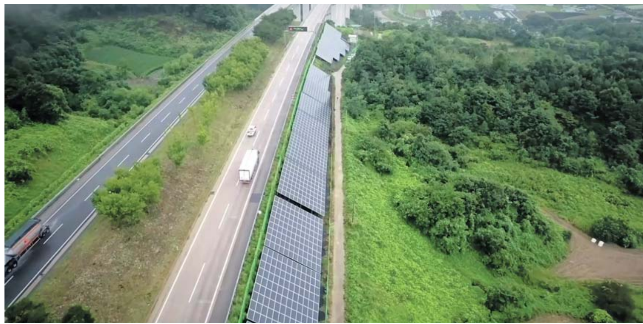
전남도가 국내 최초로 공공주도 방식의 고속도로 법면 태양광 시범사업 부지를 확정하고 발전 사업 허가 절차를 밟고 있다. 시범사업 부지는 담양IC 인근 고속도로 법면 1만983㎡ 면적으로 1.2MW 발전 규모다. 사진은 국내 한 고속도로 법면에 설치돼 있는 태양광 발전 시설 모습. <한국도로공사 제공>
