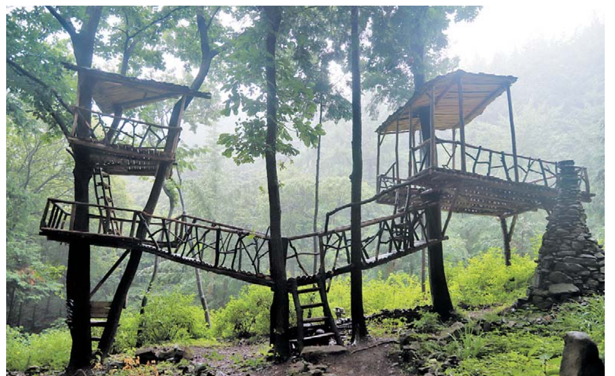
나무에 지어놓은 정자형 트리하우스. 한 나무에서 세 개의 줄기가 솟은 나무줄기를 기동삼아 삼층 정자를 만들어놓았는데, 멀리서 보면 그 모습이 거대한 새집 같다.
