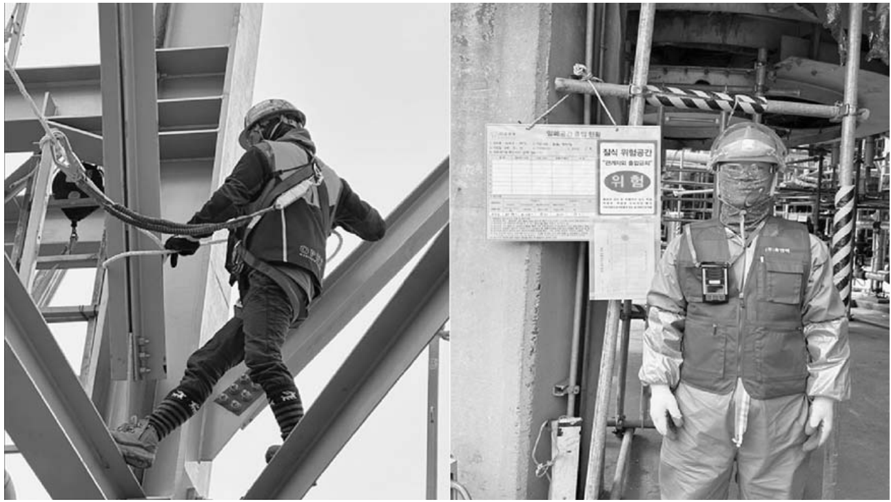
GS칼텍스 여수공장 작업자가 추락보호 안전장치(왼쪽)와 스마트 가스감지기 등을 착용하고 안전 대정비작업을 수행하고 있다. <GS칼텍스 제공>
