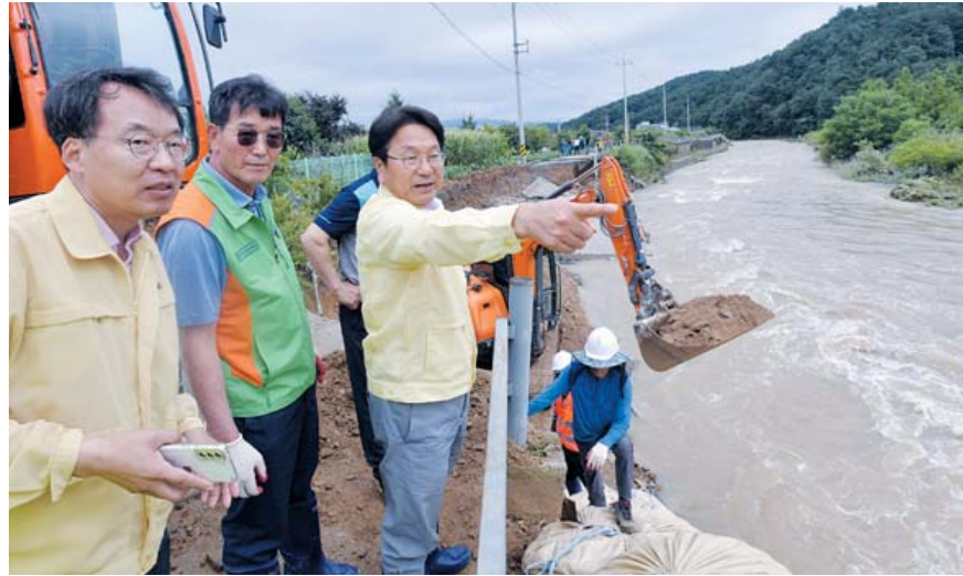
광주·전남에 많은 비가 내린 28일 강기정 광주시장이 제방이 유실된 북구 석곡천을 찾아 피해 상황을 점검하고 있다(사진 왼쪽). 김영록 전남지사가 함평군 학교면 함평군재난안전대책본부를 찾아 실종자 수색 현황에 대한 설명을 듣고 있다.
