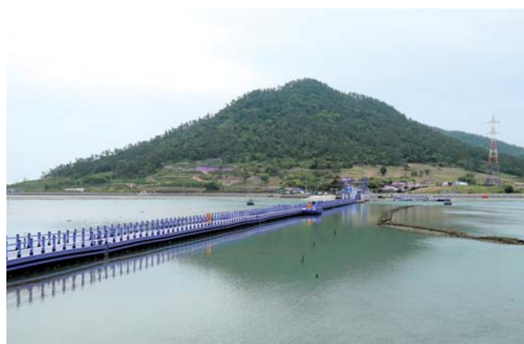
문브릿지는 바닷물의 수위에 따라 위 아래로 움직이는 부교(뚝 다리)다. 문브릿지를 건너 뒤돌아보니 보라색 다리와 보라색 지붕을 한 마을이 푸른 바다·섬 산과 행복하게 조화를 이뤘다.
