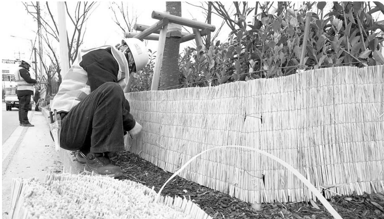
가로화단 보호막 설치 12일 오전 광주 북구청 공원녹지과 도시녹화팀 직원들이 관내 오통동의 한 도로 가로화단에서 겨울철 눈과 바람, 제설용 염화칼슘으로부터 풀과 나무를 보호하기 위해 빗집으로 만든 거울을 설치하고 있다. <광주북구제공>
