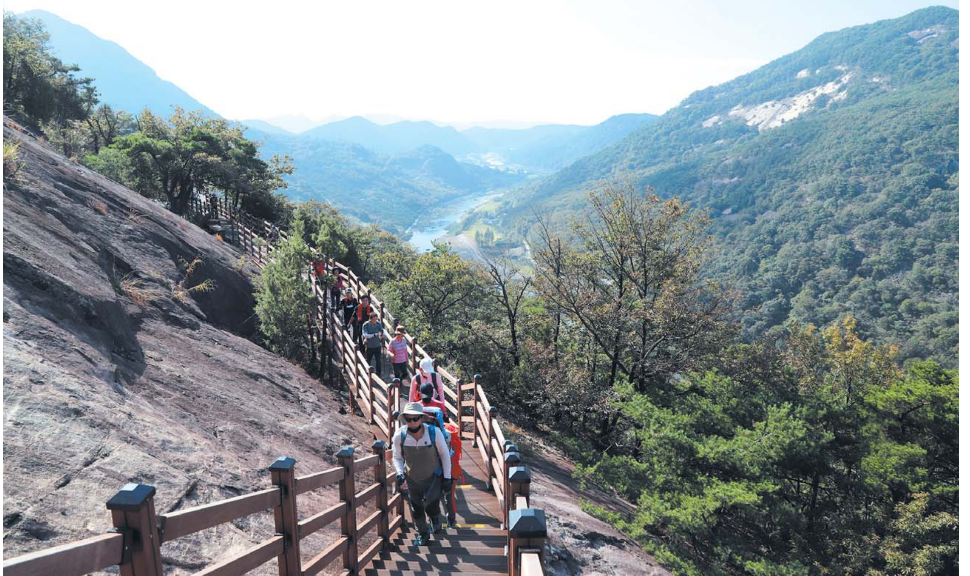
용굴산 바위절벽에 잔도가 만들어졌다. 잔도 이름이 '용굴산 하늘길'이다. 용굴산 4부 능선을 따라 이어지는 잔도는 길이가 540m에 이른다.
