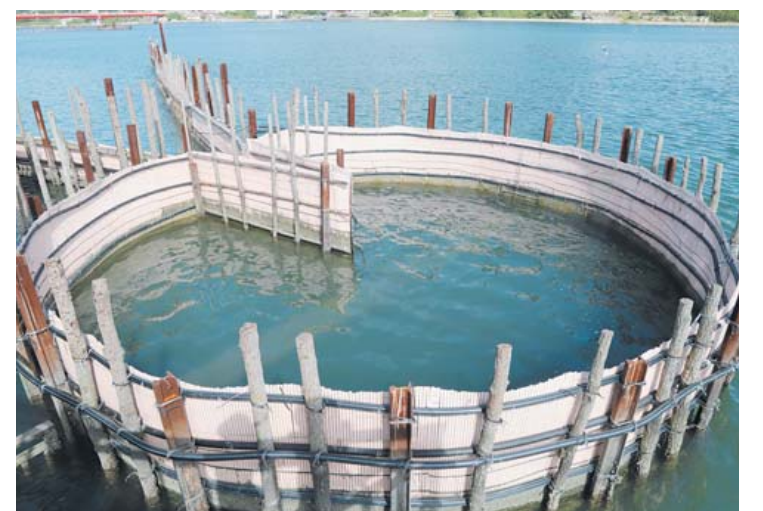
죽방렴은 좁은 바다 물목 갯벌에 참나무 지지대 300여개를 박고 대나무 밧을 V자로 벌려 물살에 떠내려 온 고기가 원형의 커다란 통 속에 갇히도록 하는 방식이다.
