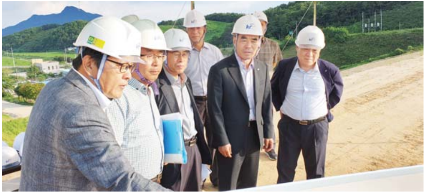
김인식 한국농어촌공사 사장이 최근 순창군 팔덕면 소재 다목적농촌용수개발사업 현장을 방문해 시설물 안전관리 및 농업용수 공급 상황 등을 점검했다.
