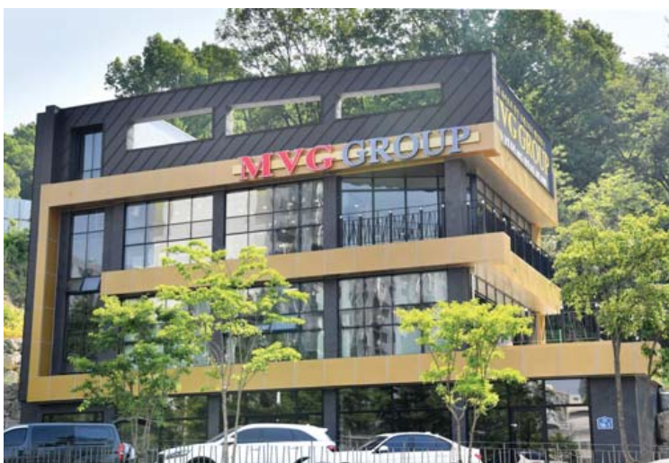
MVG그룹 본사 사옥 전경.
