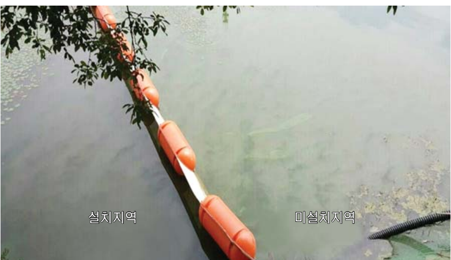
현진엔지니어링이 광주 서구 풍암저수지에 설치한 국내 최초 초음파를 활용한 녹조제거 시스템(좌). 시연 후 설치지역과 미설치지역간 녹조발생 요인인 염록소 수치가 확연하게 차이나 주목받고 있다.
