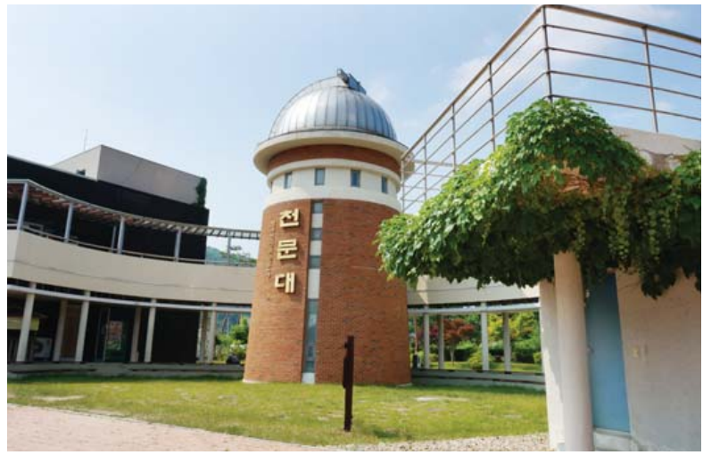
특히 비바람을 피하는 닫힌 공간인 듯하면서도 액자 모양의 창을 통해 들어온 자연을 새롭게 바라보고 동시에 자신을 또 다른 시각에서 바라볼 수 있는 열린 공간으로 만들었다.
